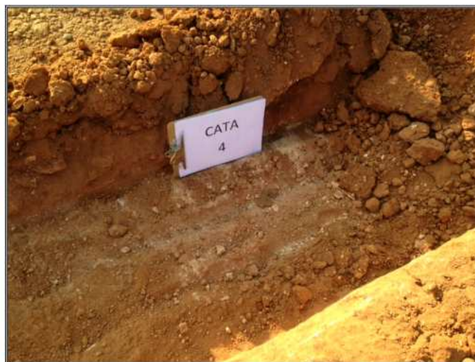
Vista general de la calicata CA-04
