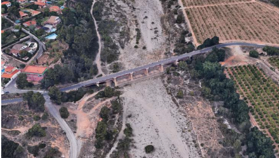
Puente de la CV-189, entre los términos municipales de Castelló y Onda. Captura de Google Maps.
