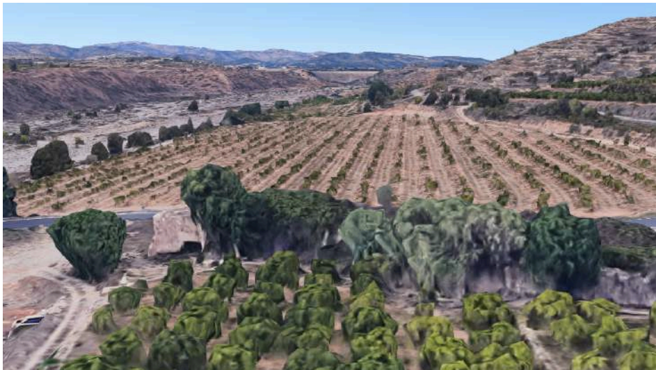
Edificación antigua en estado de ruina, junto a la CV-189. Captura de Google Maps.
